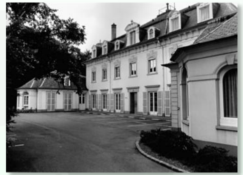
Ancienne villa Koechlin au Hasenrain
