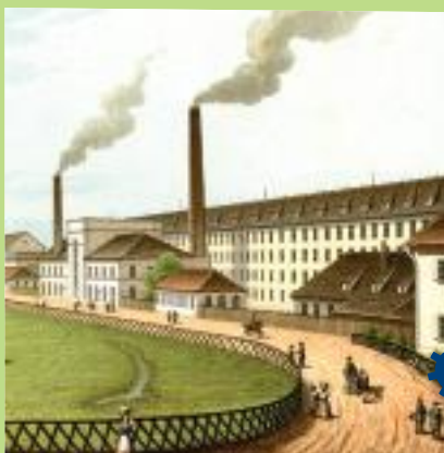
Entreprise Dollfus, Mieg et Cie - vue de Pedraglio
