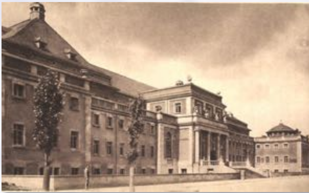
Les Bains municipaux de Mulhouse, rue Curie 1925
